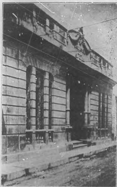
Fachada del moderno y hermoso edificio que ocupan las oficinas del Banco Español de Sancti Spiritus, propiedad del Administrador del mismo, Sr. Fernando J. Cancio.
